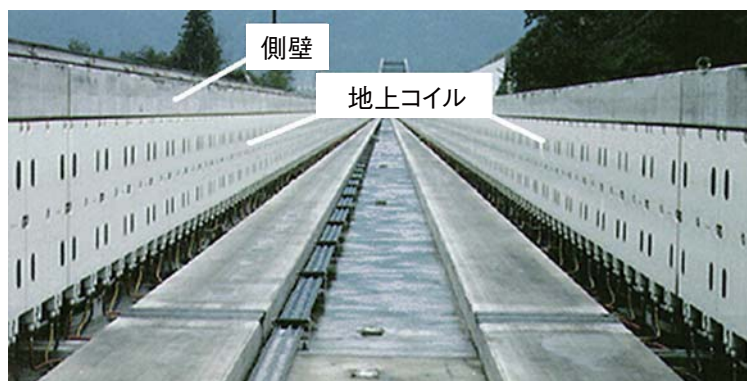
図2 ガイドウェイへの地上コイル敷設状況
