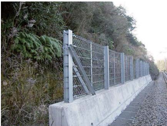
図2 線路際に柵等を設置する対策の例
