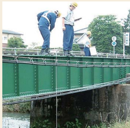
図1 橋りょうの検査作業の様子
