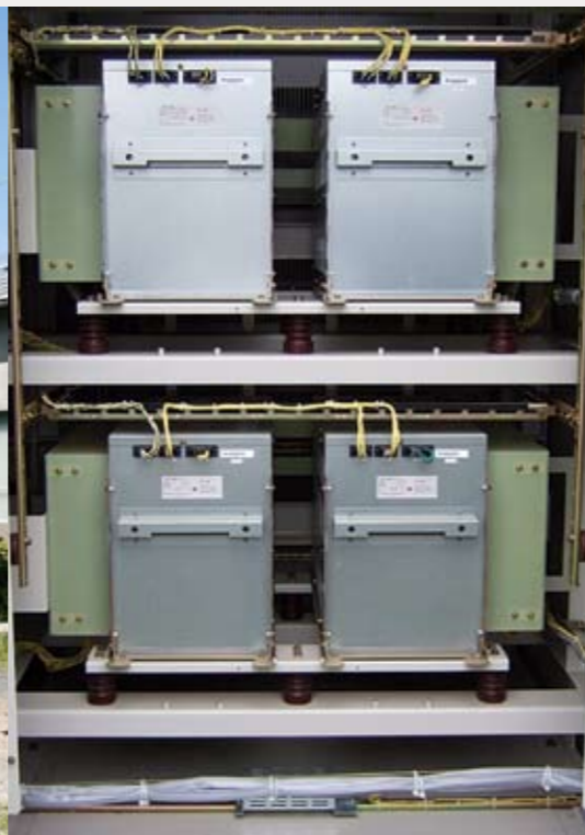
電車が回生ブレーキを使用した際に発生するエネルギーを蓄える電力貯蔵装置です。「電気二重層キャパシタ」という媒体に電力を貯蔵します(写真右)。蓄えた電力を有効に活用するための最適な制御方法を研究しています。
