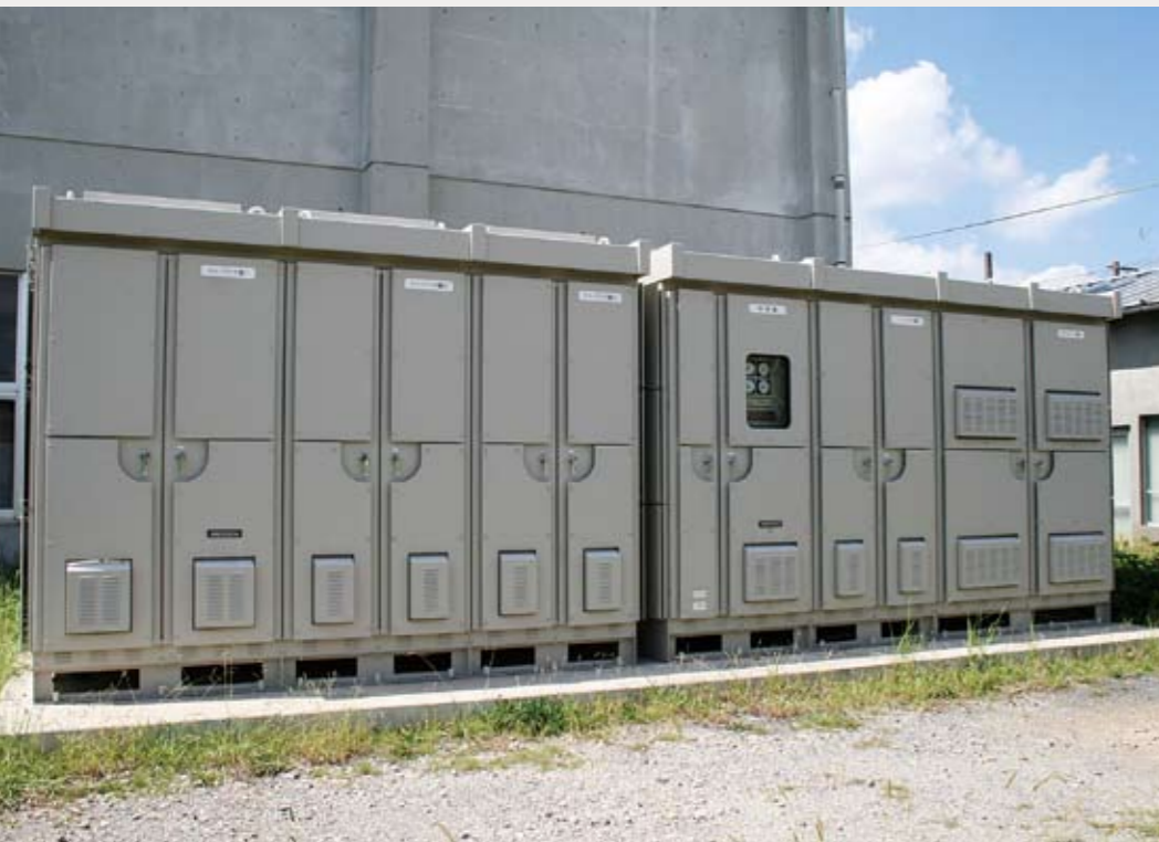
電車が回生ブレーキを使用した際に発生するエネルギーを蓄える電力貯蔵装置です。「電気二重層キャパシタ」という媒体に電力を貯蔵します(写真右)。蓄えた電力を有効に活用するための最適な制御方法を研究しています。
