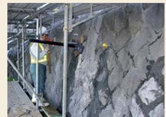
図3 施工状況(1次施工・削孔)
