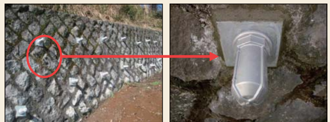
図4 施工後の状況
