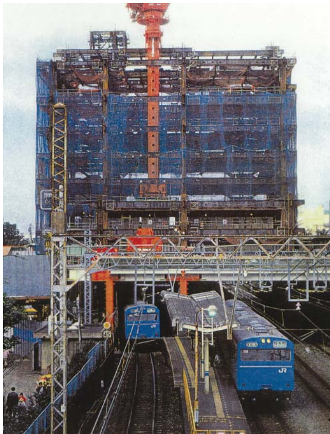
図3 建設中の大井町駅ビル
