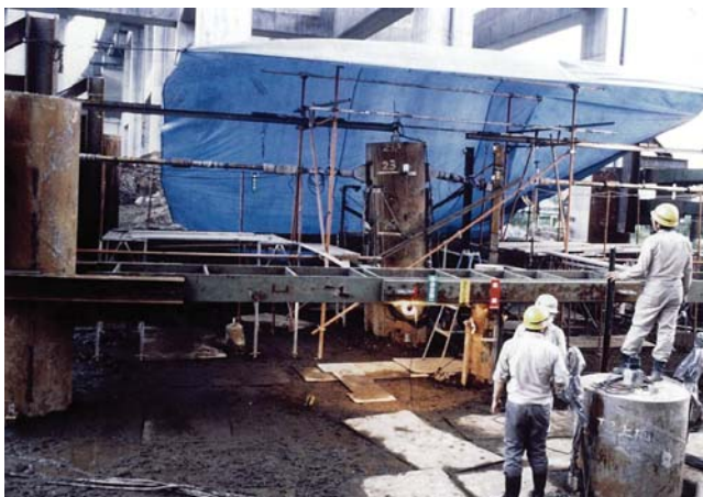
図1 突出杭の水平載荷試験
