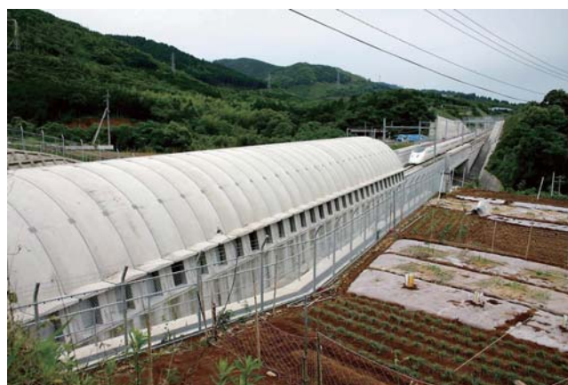
図4 トンネル坑口に設置されている入口緩衝工
