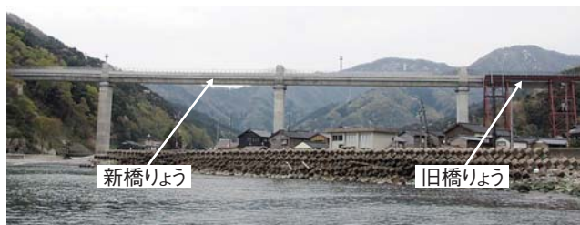
図10 新余部橋りょう (JR西日本山陰線)
