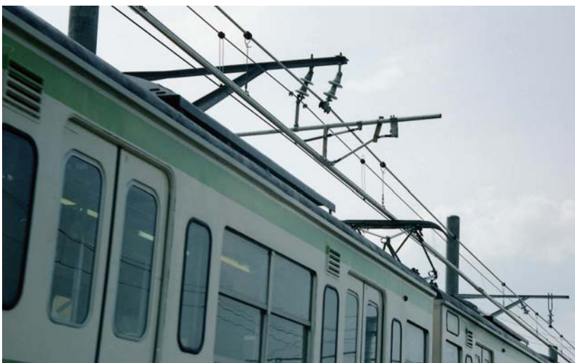
図3 訓練線で試験中のカテナリ式剛体電車線
