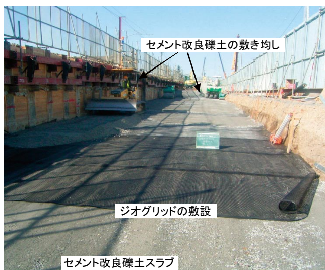
図3 セメント改良礫土スラブの施工の様子
