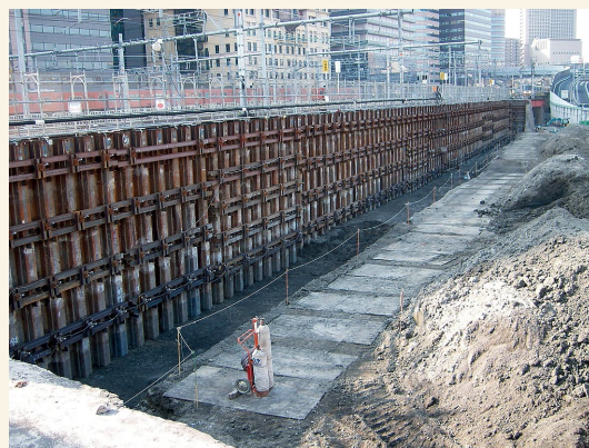
図2 ラディッシュアンカー施工状況(当時)
