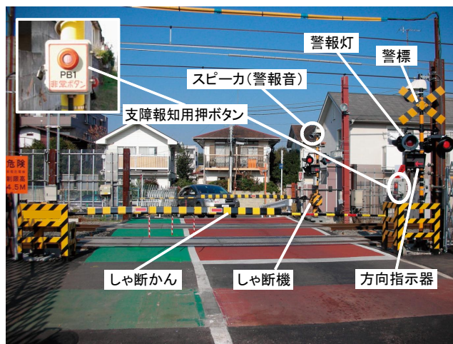
図1 踏切保安装置の例
