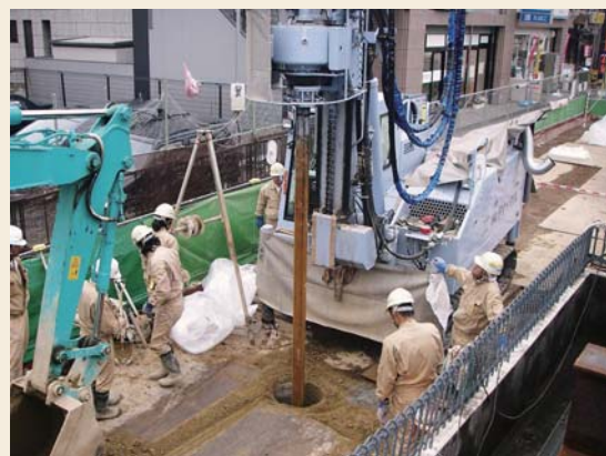
図2 ポリマー免震壁削孔状況
