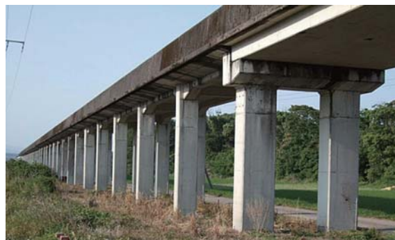
図1 コンクリート高架橋
