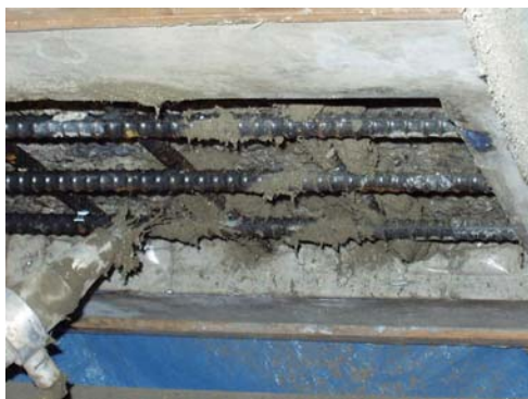
図8 断面修復材の吹き付け施工
