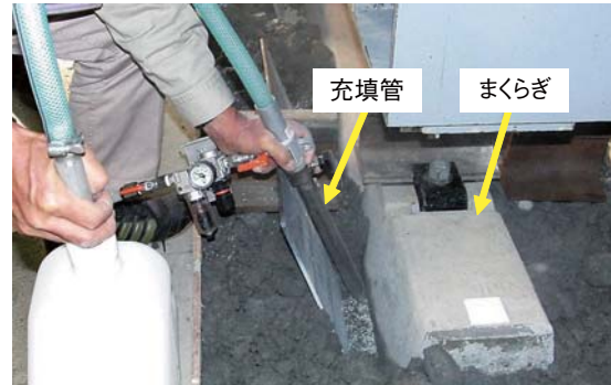
図13 粒状充填材の充填
