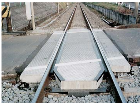
図3 開発時の総研型踏切舗装版
