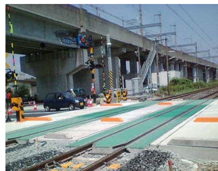
図4 ゴム貼型の総研型踏切舗装版
