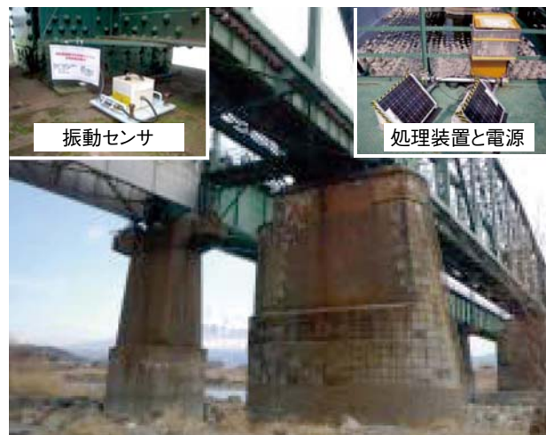
図2 測定した橋脚とシステムの設置状況
