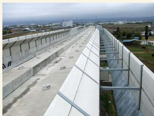
図2 側方開床式高架橋(北陸新幹線)
