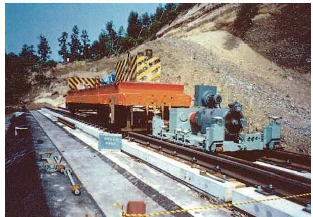
図11 軌道繰り返し載荷試験の状況(北陸新幹線榎山地区)
