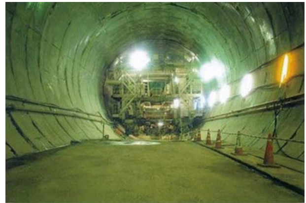
図18 SENS工法の施工状況
