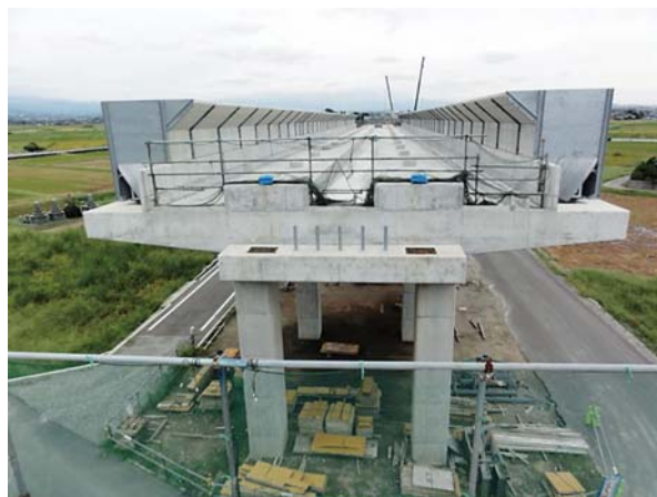
図2 建設中の高架橋横断面
