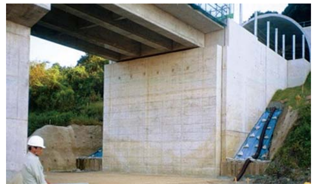
図16 セメント改良補強土橋台 (九州新幹線多・新八代間 高田付近)
