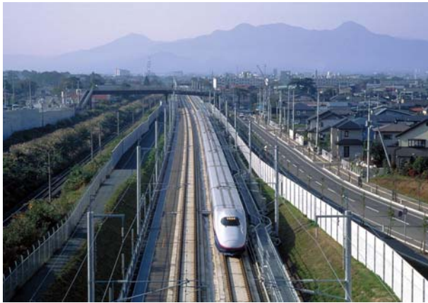
図12 スラブ軌道用土構造物 (東北新幹線八戸・新青森間, 茨島付近RC路盤)
