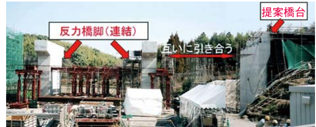
図14 セメント改良補強土橋台の水平載荷試験
