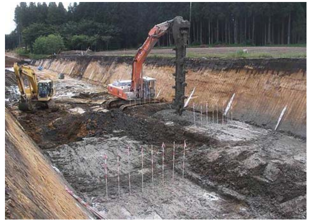
図22 事前地盤改良工の施工状況
