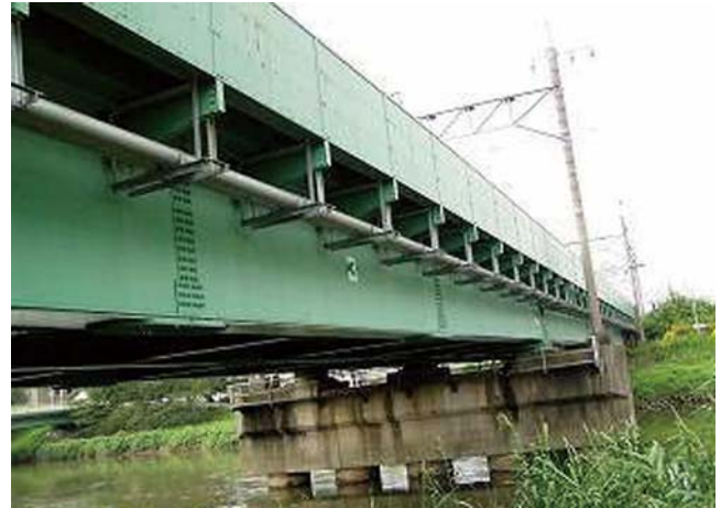
図1 実橋梁に試験塗装した「塗装系ECO 1」の外観
