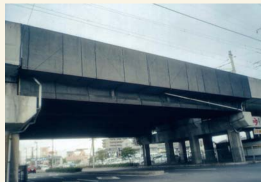
図2 はく落防止ネット施工状況
