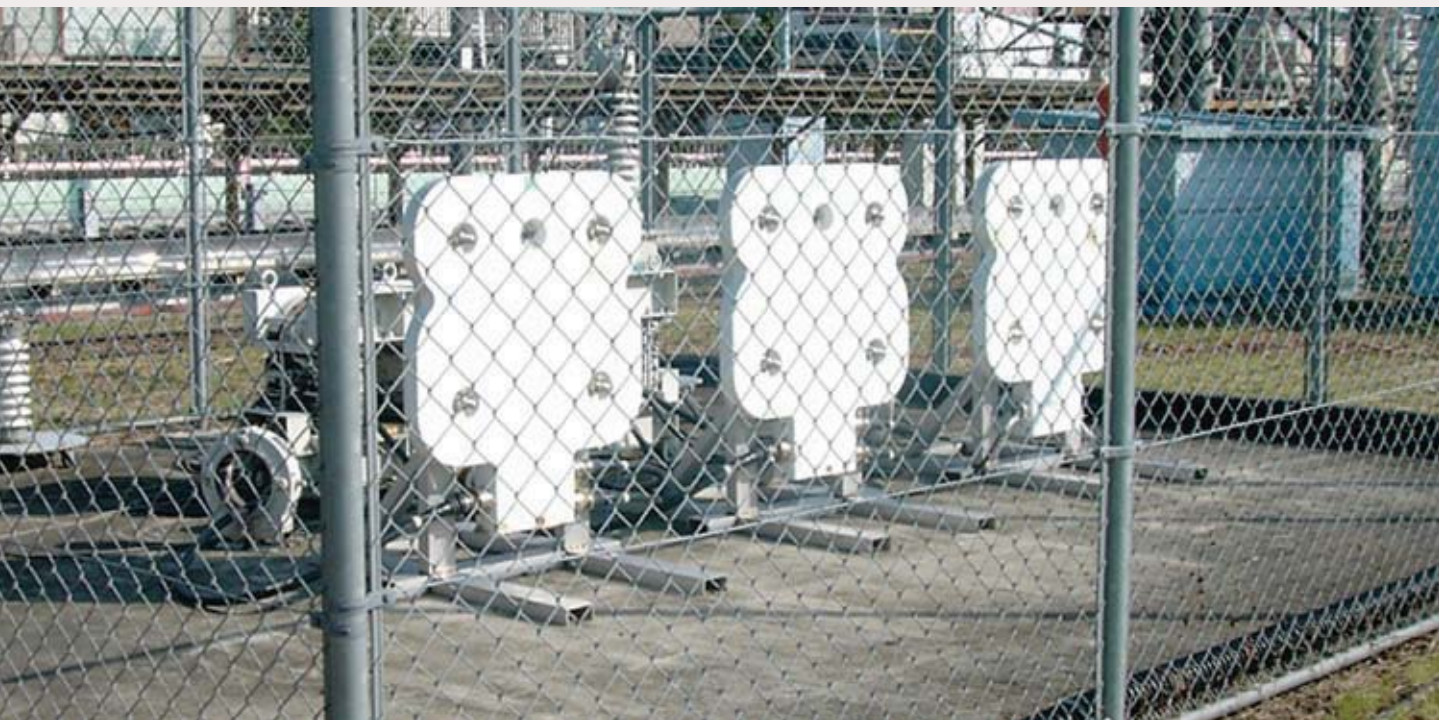
屋外にて長期間、地上コイルを高電圧で連続課電しながら通電によるヒートサイクルを加え、主として熱的・機械的観点からコイル各部の耐久性を検証します。
