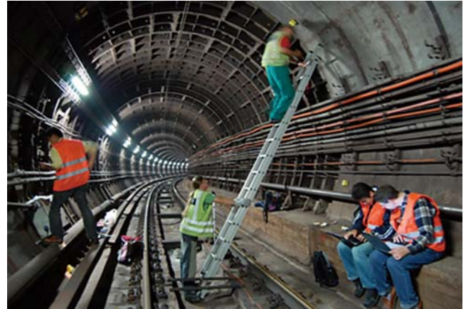
図4 ブラハ地下鉄でのシステム設置作業
