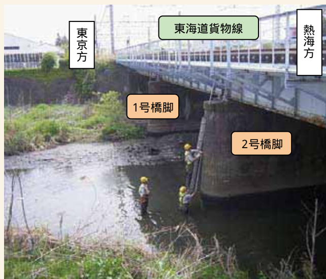
図1 茅ヶ崎川橋りょう衝撃振動試験状況
