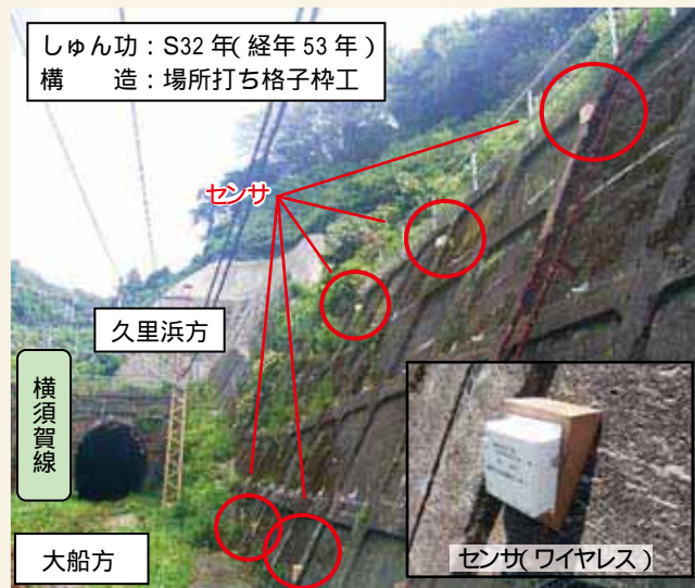
図2 横須賀線斜面防護工衝撃振動試験状況
