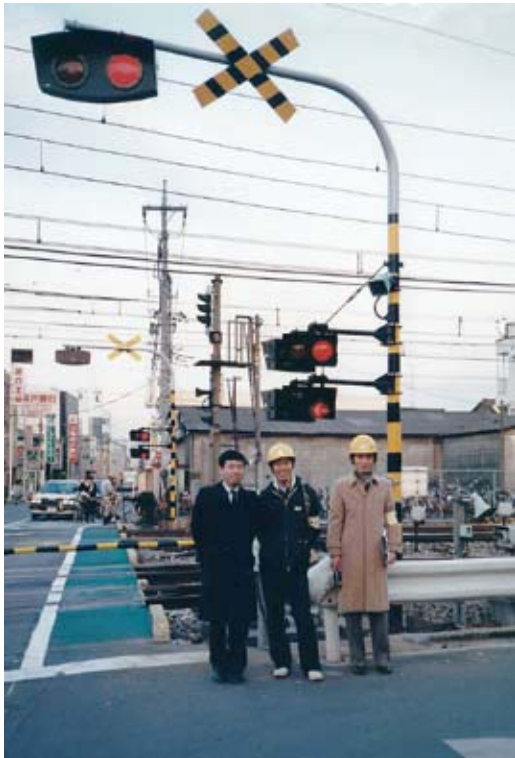
JRの踏切に試作された新型踏切(1989年1月)
