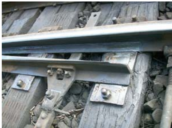
図3 先端が損傷したトングレール
