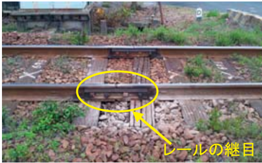
図2 ローカル線のレールの継目の例
