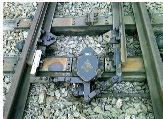
図5 ゲレンクの取付状況
