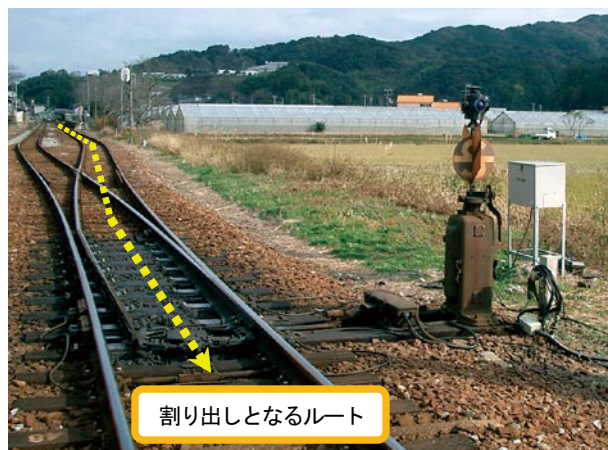
図2 SSP形（発条）転てつ機と分岐器
