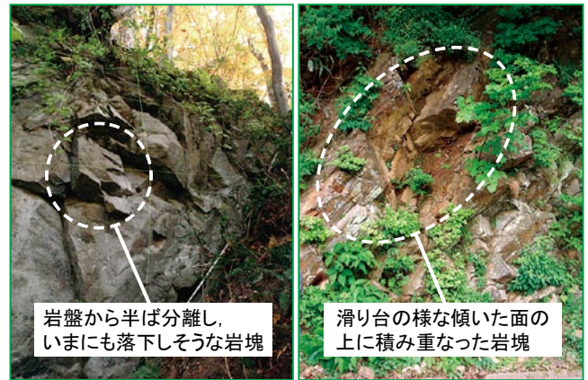
図4 岩盤斜面の状況
