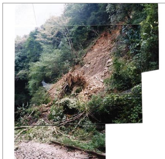
図1 斜面表層の崩壊事例
