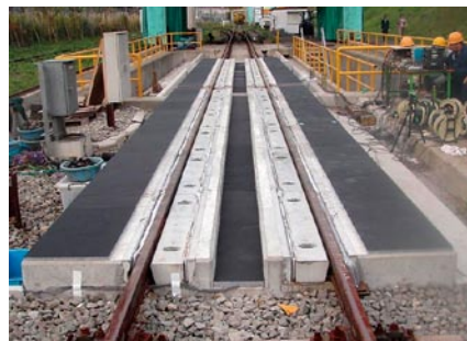
図8 吸音材設置後の新形式軌道の外観
