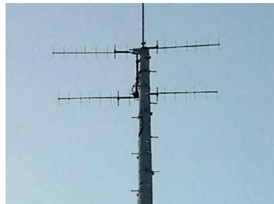
図3 基地局アンテナ
