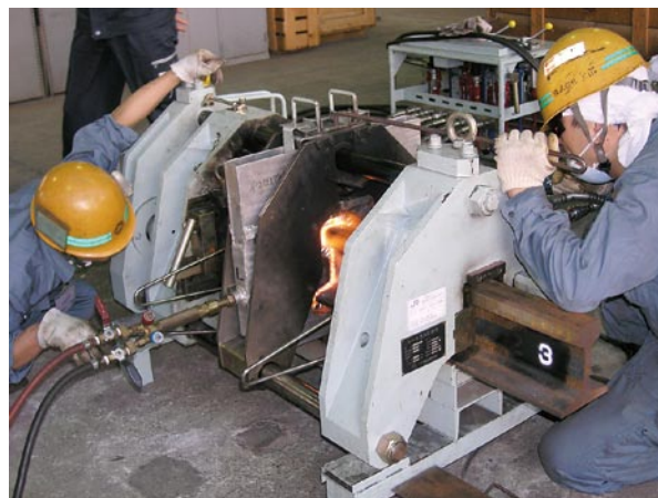
図4 試験継手作製状況
