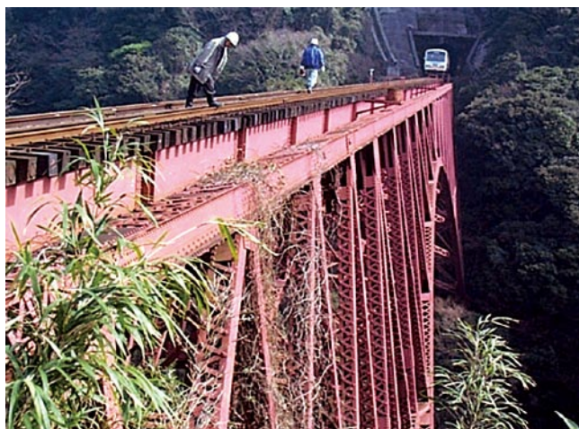
図1 全体の点検が困難な橋りょうの例
