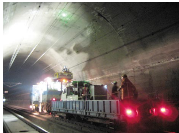
図12 新幹線トンネルでの検査の様子
