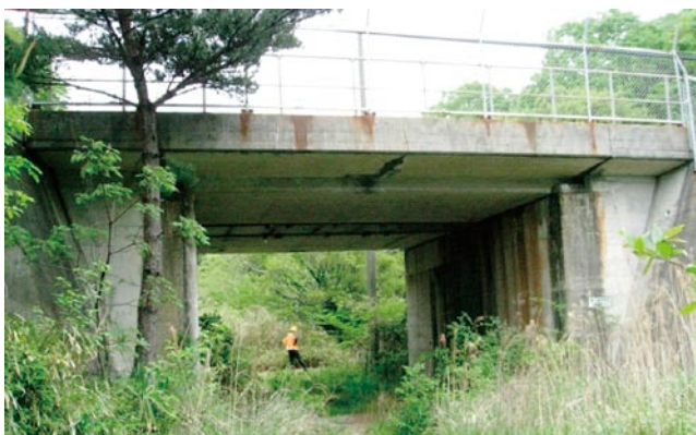
図10 検証試験で実施した新幹線橋梁
