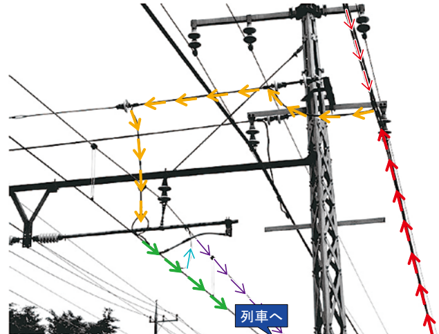
図3 架線の電気の流れ(直流区間)
