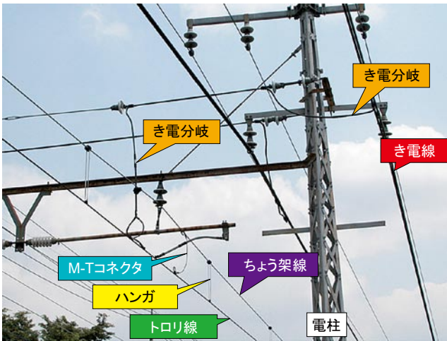
図2 架線の例(直流区間)
