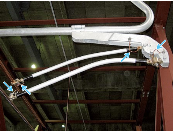
図5 曲線引金具の均圧線(矢印)
