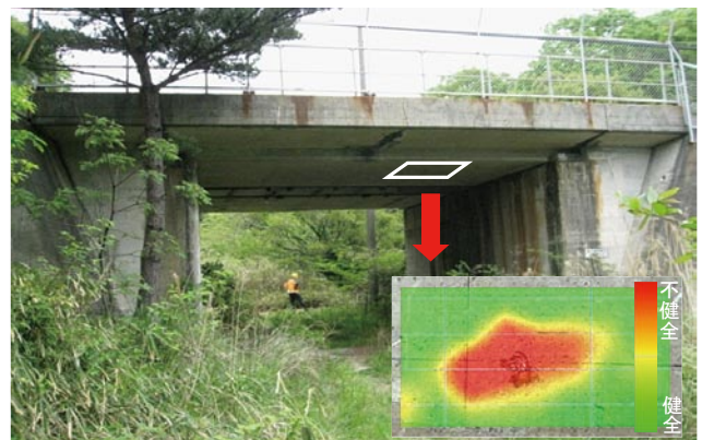
図3 レーザー加振による欠陥検出例
