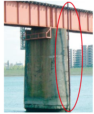
図5 水位観測用の量水標 図6 レールによる洗掘計
