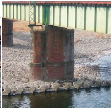
図4 橋脚周りの洗掘防護工の例
