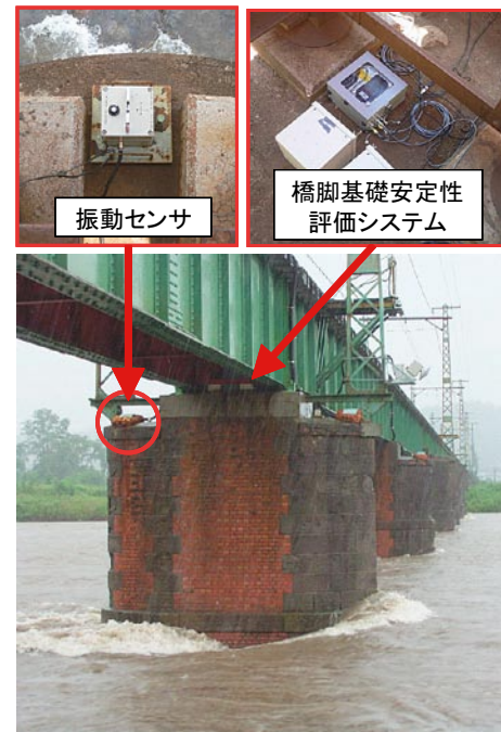
図13 システムの設置状況
