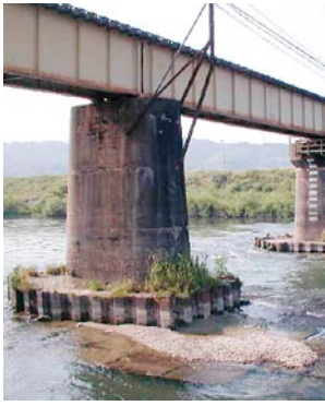
図4 橋脚周りの洗掘防護工の例
