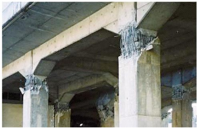
(b)軸方向鉄筋の変形
