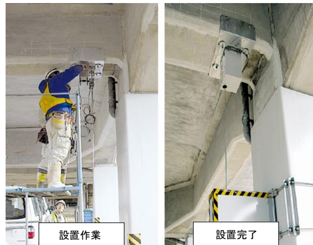
図10 新幹線高架橋への部材角測定装置設置状況
