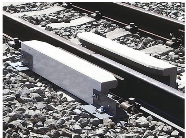
図9 レール継目用防音材の設置状況
