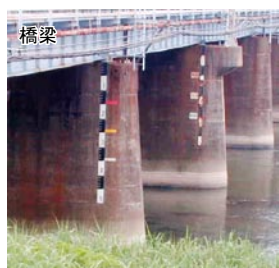
図1 橋脚につけた量水標の例 最近では、水圧や超音波を用
