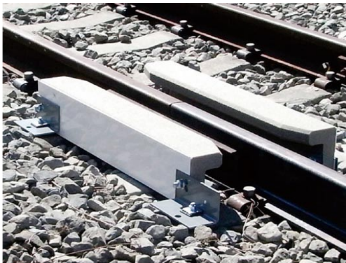
図 レール継目用防音材の設置状況
