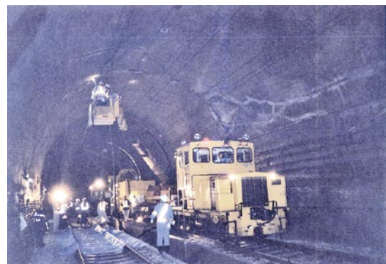
図3 車載プラントによる施工例
