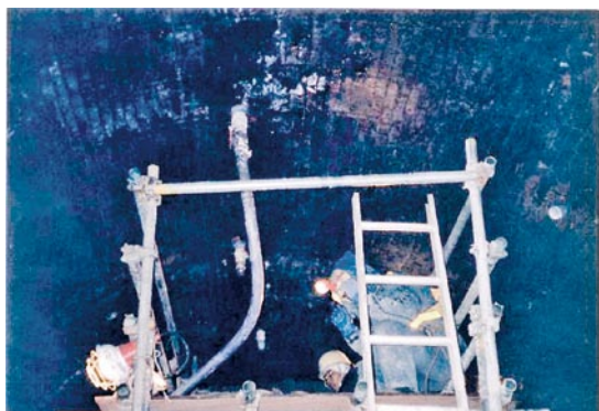
図4 初の現場施工(覆工はレンガ)
