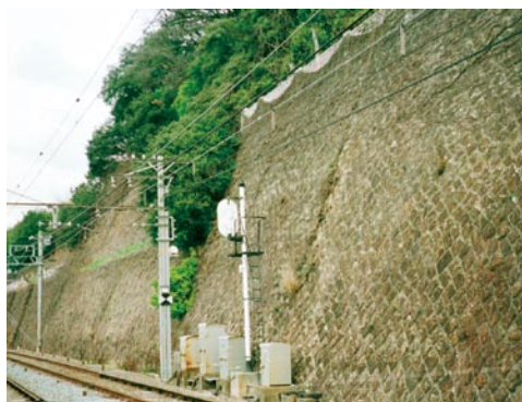
図2 切土のり面に施工された石積壁
