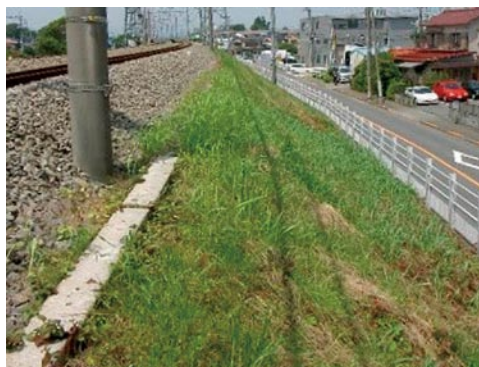
図1 盛土のり面に施工された植生工
