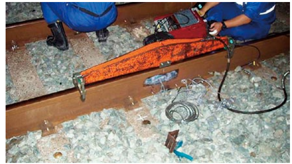
図4 輪重検定作業
