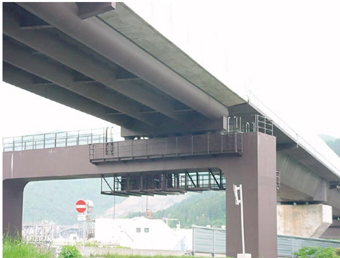
図 世界で初めてNi系高耐候性鋼材を採用した 北陸新幹線 北陸道架道橋 (写真提供: 鉄道・運輸機構, 新日鐵株)
