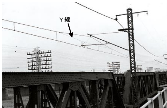
図4 変形Y形シンプル架線
