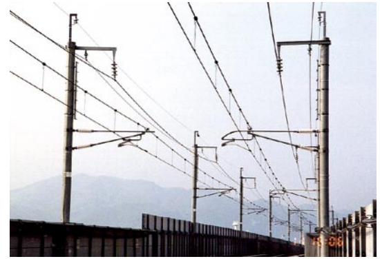
図9 CSシンプル架線
