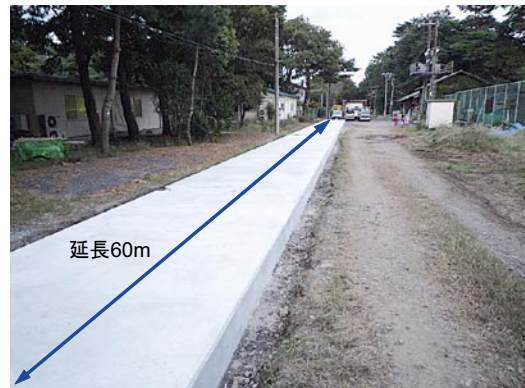
図20 ビニロン繊維補強コンクリートによる路盤
