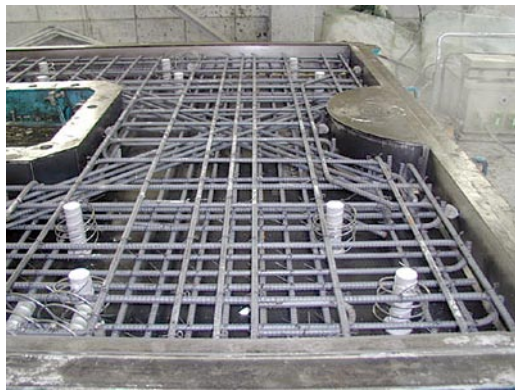
図5 軌道スラブの配筋の状況
