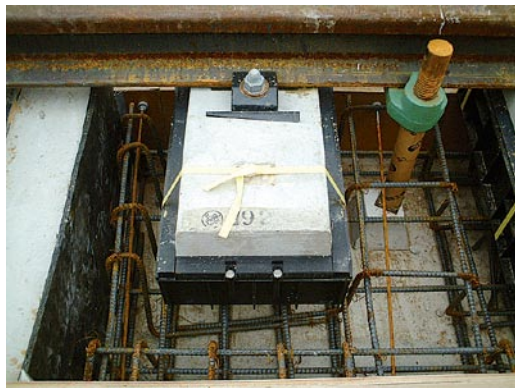
図7 まくらぎ直結軌道の配筋の状況
