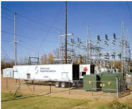
図6 変電所に導入されたD-SMES 13)
