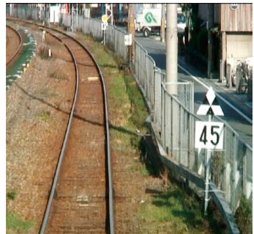
図3 試験用に仮設した徐行予告信号機
